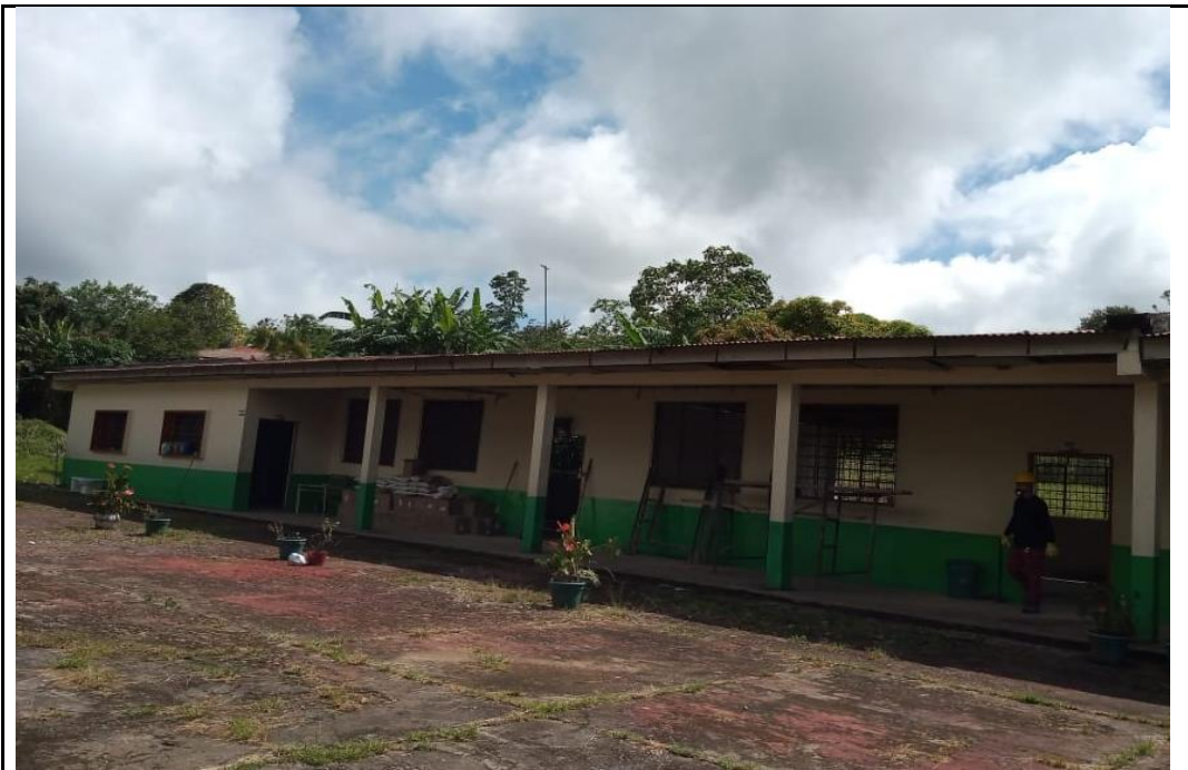
1. I.E.San Andres - Sede Principal (Dolores - Tolima) AVANCE DE OBRA : .
