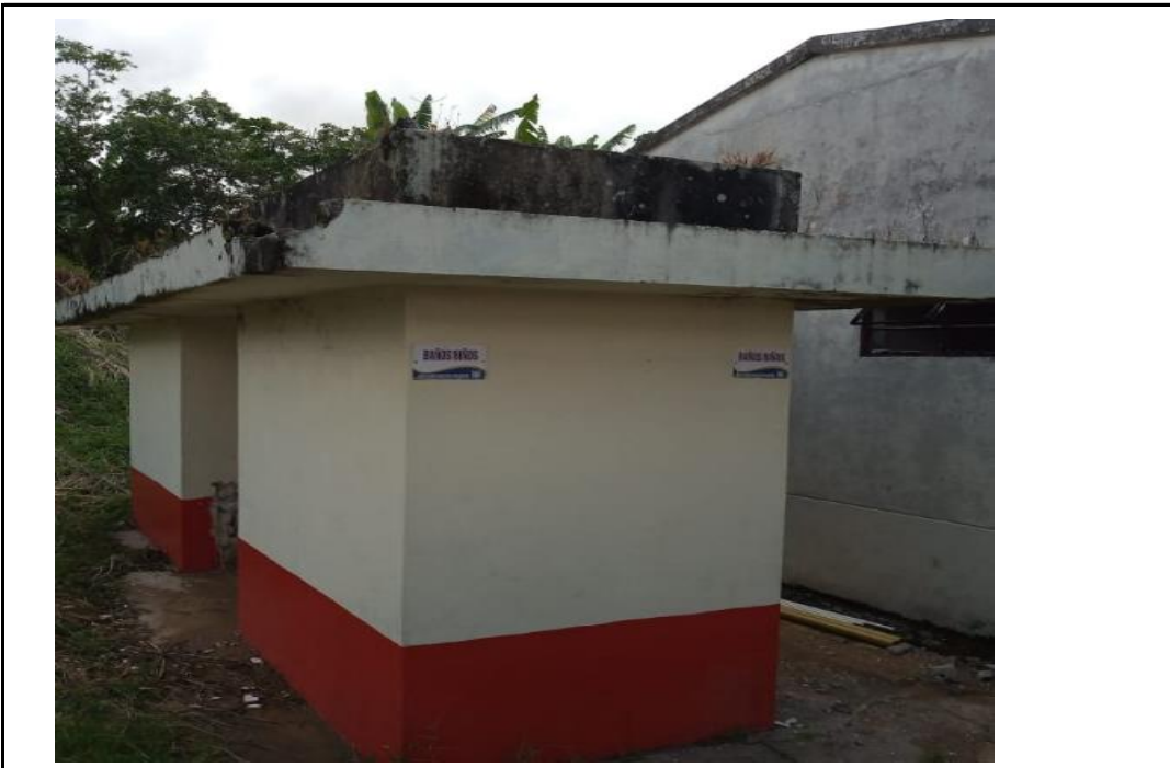
1. I.E. San Andres _ Sede Principal ( Dolores- Tolima) AVANCE DE OBRA :
